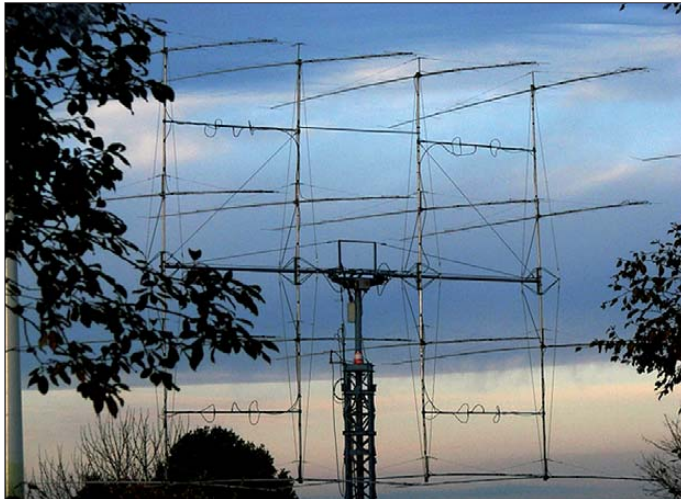
Der Standort von DF0MU befindet sich in JO32PC auf dem Schöppinger Berg (157,6 m ü. NN), einem Ausläufer der Baumberge im westlichen Münsterland. Neben dieser günstigen UKW-Lage tragen vor allem die 16 Yagi-Antennen zum Funkerfolg bei.
